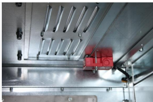
Рис. 13 Концевой выключатель в отсеке сборных шин ВССШ
