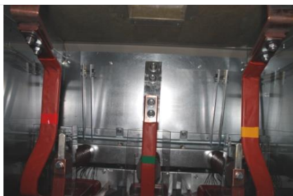
Рис. 6 Отсек присоединений НССШ
