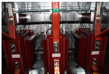
Рис. 6 Отсек присоединений НССШ
