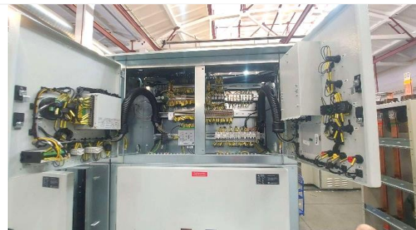
Рис. 9 Отсек вспомогательных цепей (вид при открытой двери)
