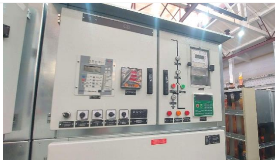
Рис. 8 Фасад отсека вспомогательных цепей
