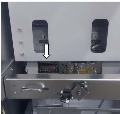
Рис. 14 Концевые выключатели на ВЭ
