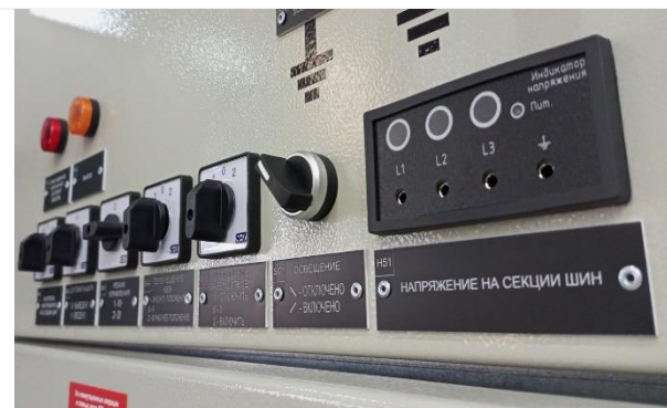
Рис.11 Индикатор наличия напряжения
