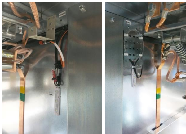
Рис.6 Оптический датчик в отсеке присоединений
