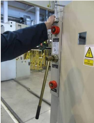
Рис. 2.12 Перемещение изоляционной плиты
