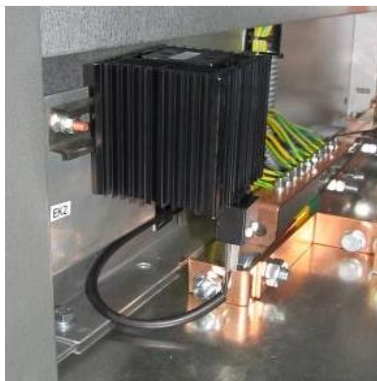
Рис. 1.44 Антиконденсатный нагревательный элемент
