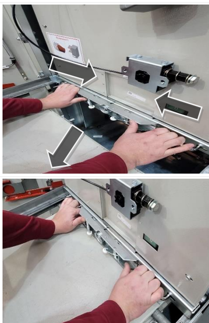
Рис. 2.18 Извлечение КВЭ на сервисную тележку
