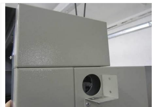
Рис.1.8 Отверстия для прокладки межсекционных связей
