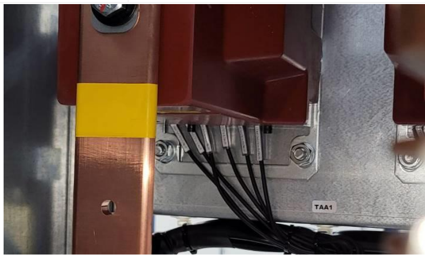
Рис. 3.7 Подключение вспомогательных цепей к ТТ
