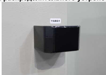
Рис. 1.30 Электромагнитная блокировка заземлителя
