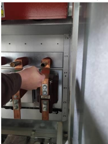
Рис. 3.6 Демонтаж контактов (пример)
