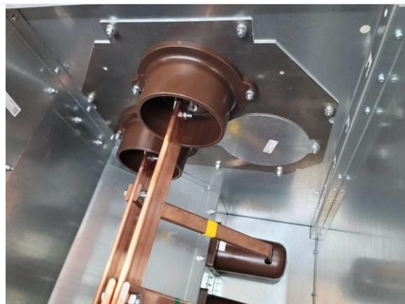
Рис.1.3 Опорный изолятор сборных шин в крайнем шкафу секции КРУ
