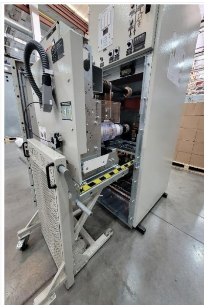
Рис. 2.19 КВЭ в ремонтном положении
