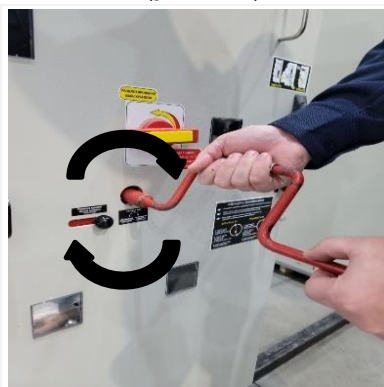
Рис. 2.4 Фиксация ручки перемещения
