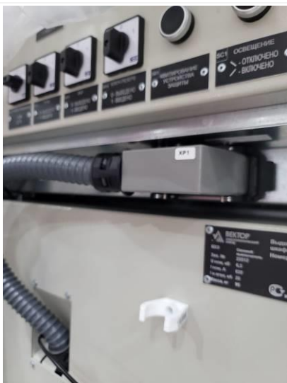
Рис. 2.21 Отсоединение разъема вторичных цепей
