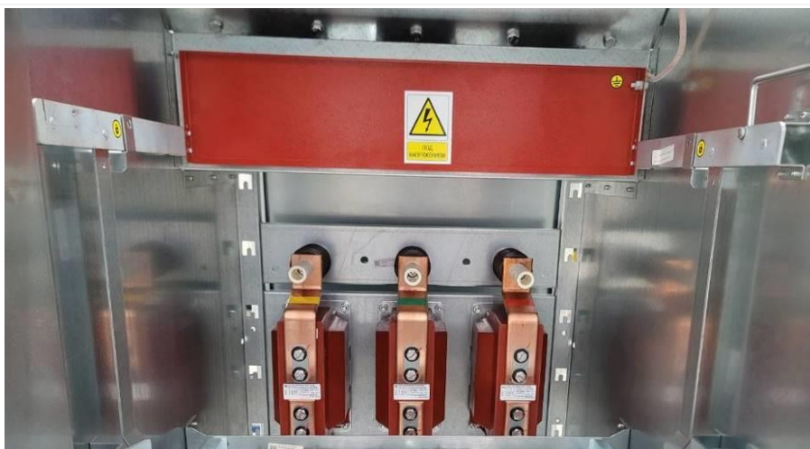
Рис.3.8 Крепление трансформаторов тока
