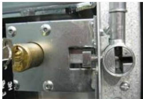
Рис. 1.32 Замковая блокировка оперирования заземлителем
