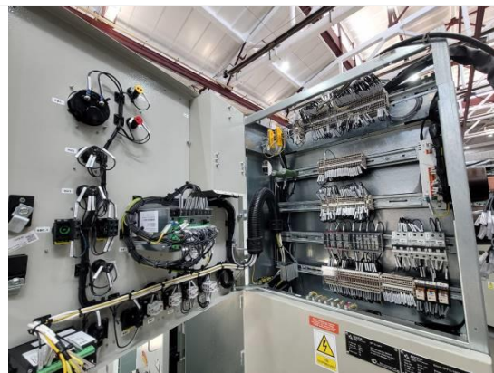
Рис.1.7 Отсек вспомогательных цепей (вид при открытой двери)
