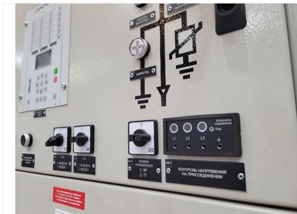
Рис. 1.19 Индикатор наличия напряжения
