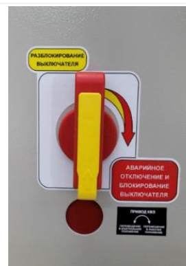
Рис. 2.5 Разблокирование вакуумного выключателя
