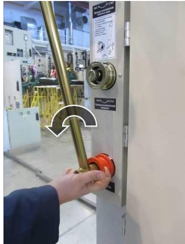
Рис. 2.13 Отключение заземлителя
