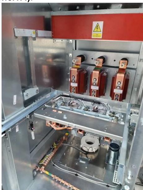
Рис.1.4 Совмещенный высоковольтный отсек
