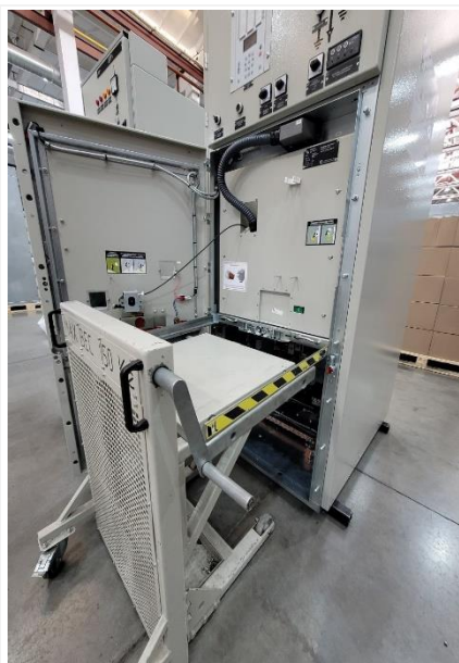
Рис. 2.17 Стыковка и фиксация инвентарной сервисной тележки
