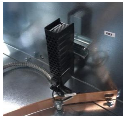
Рис. 1.44 Антиконденсатный нагревательный элемент
