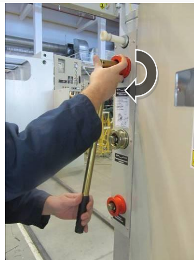
Рис. 2.16 Включение заземлителя СШ
