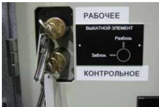
Рис. 1.31 Замковая блокировка перемещения КВЭ
