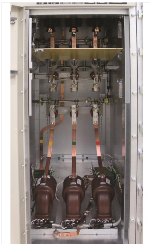
Рис 1.24 Выключатель нагрузки в шкафу со стационарно размещенным ТН
