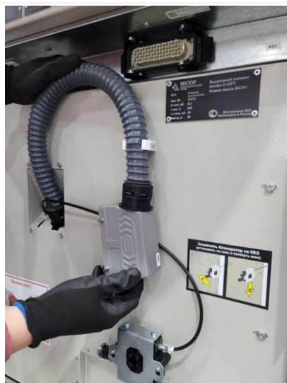
Рис. 2.21 Отсоединение разъема вторичных цепей
