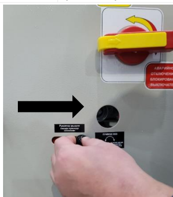
Рис. 2.3 Доступ к гнезду оперирования КВЭ
