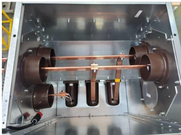
Рис.1.2 Отсек сборных шин (вид сверху при снятых клапанах сброса давления)
