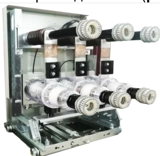
Рис.1.12 КВЭ с вакуумным выключателем ISM15_LD
