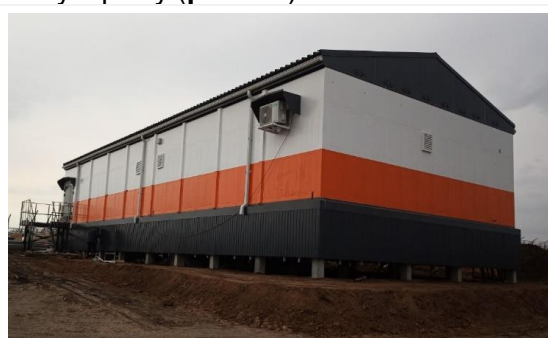
Рис. 16 Установка КТПМ на сваи
