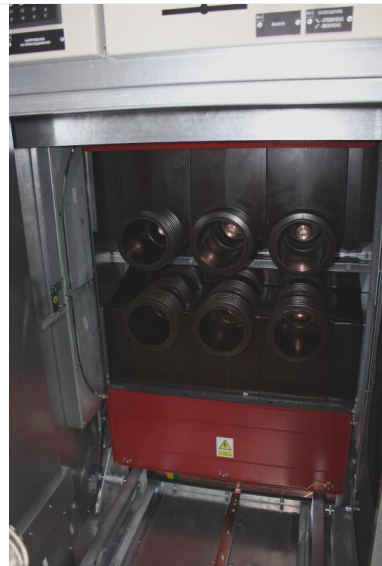
Рис. 24 Отсек выкатного элемента
