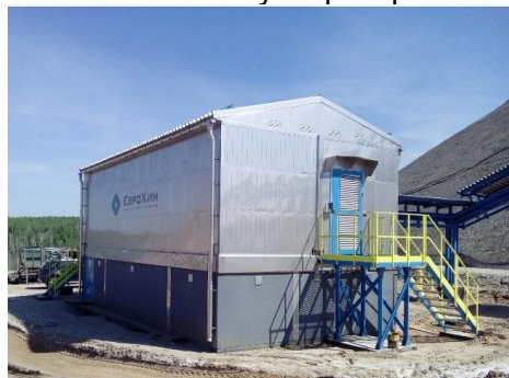
Рис. 15 Установка КТПМ на бетонный кабельный полуэтаж
