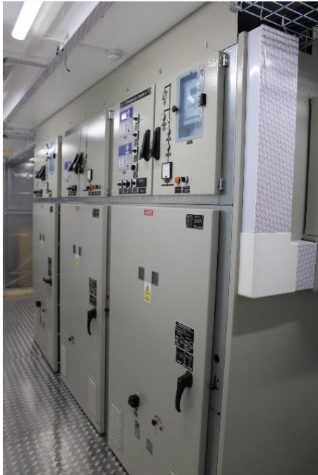
Рис. 21 Комплектное распределительное устройство серии D-40P
