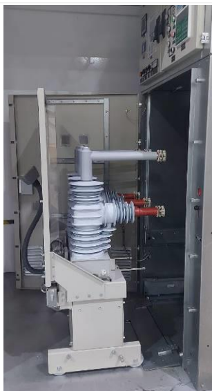
Рис. 23 Выдвижной элемент с выключателем Smart35
