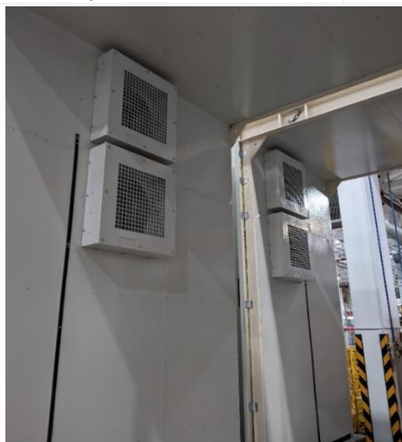
Рис. 52 Принудительная вытяжная и приточная вентиляция
