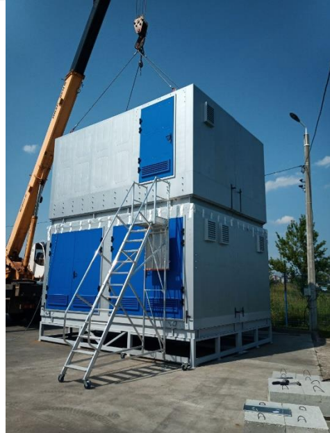
Рис. 18 Установка КТПМ на стальную пространственно-стержневую раму
