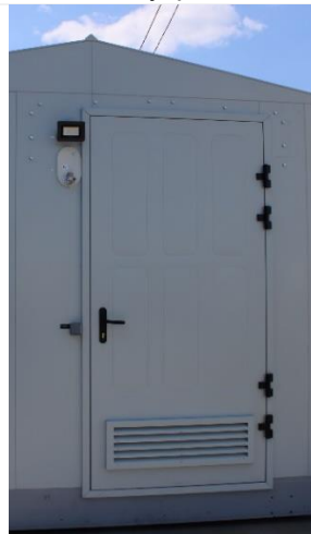
Рис. 52 Принудительная вытяжная и приточная вентиляция
