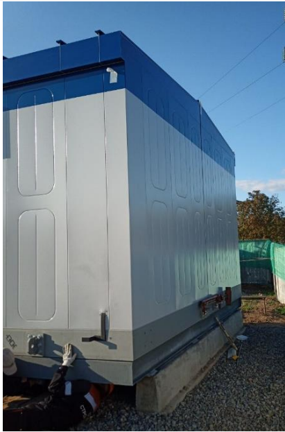
Рис. 17 Установка КТПМ на лежни
