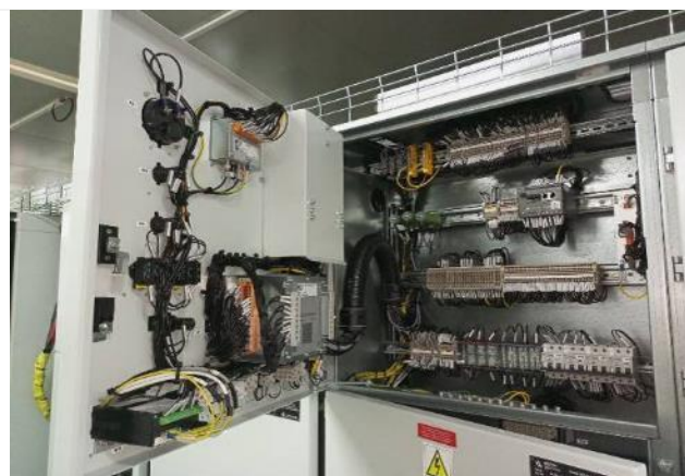
Рис. 8 Отсек вспомогательных цепей (вид при открытой двери)
