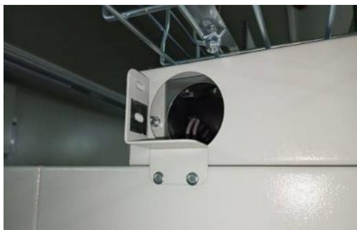
Рис. 9 Отверстия для прокладки межсекционных связей
