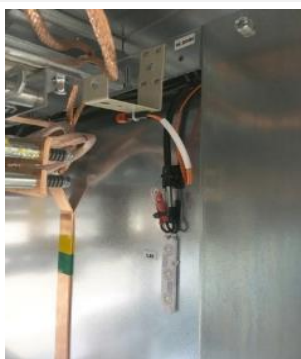
Рис.12 Волоконно-оптический датчик в отсеке присоединений
