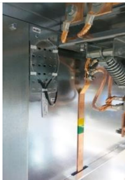
Рис.12 Волоконно-оптический датчик в отсеке присоединений
