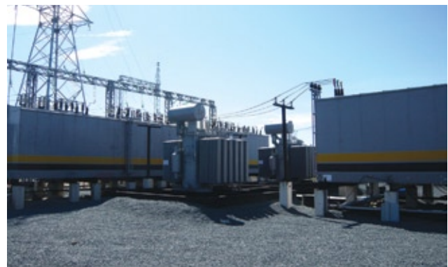
Пример Т-образной компоновки двухтрансформаторной КТПМ СКР 35/6(10) кВ
