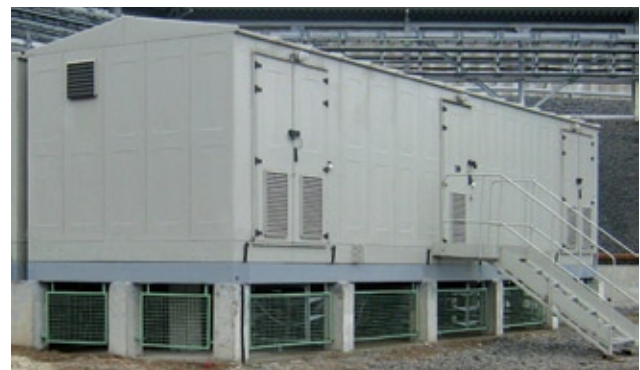
Пример компоновки двухтрансформаторной КТПМ СКР 6(10)/0,4 кВ
