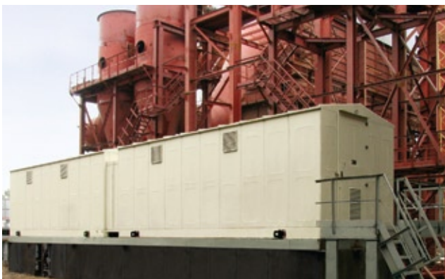
Линейная компоновка модулей
