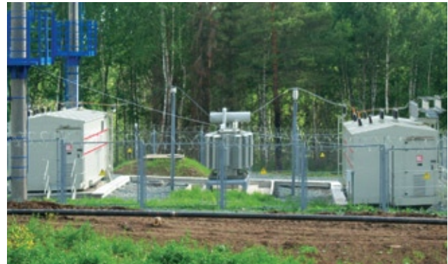
Пример компоновки однострансформаторной КТПМ СКР 35/6(10) кВ
