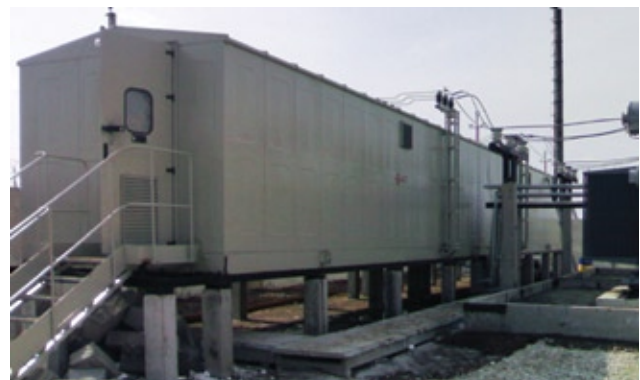
Пример H-образной компоновки двухтрансформаторной КТПМ СКР 35/6(10) кВ
