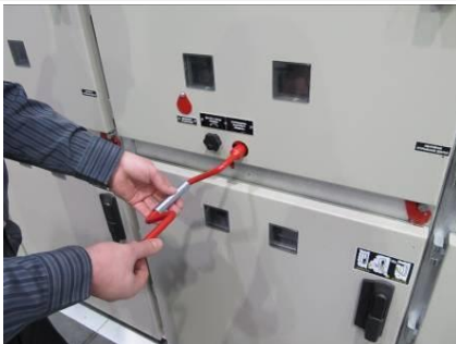
Рис. 2.4 Фиксация ручки перемещения
