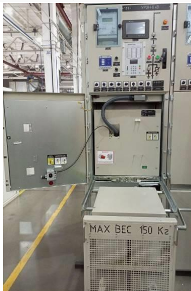
Рис. 2.18 Стыковка и фиксация сервисной тележки
