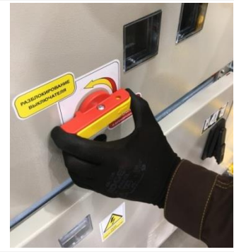
Рис. 2.8 Разблокирование вакуумного выключателя
