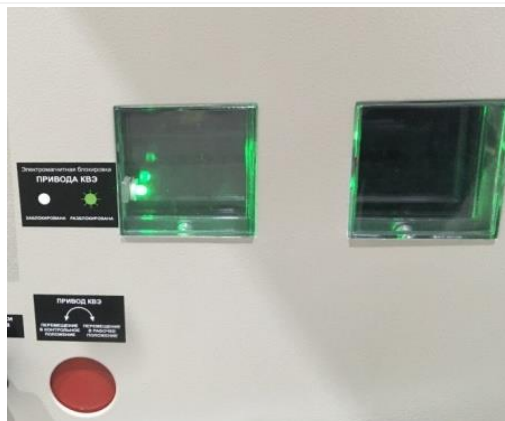
Рис. 2.34 Индикация электромагнитной блокировки
