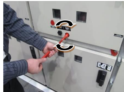
Рис. 2.5 Вращение винтовой передачи КВЭ
