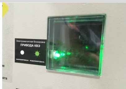
Рис.1.30 Электромагнитная блокировка КВЭ
