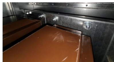
Рис. 3.7 Разблокирование нижней шторки
