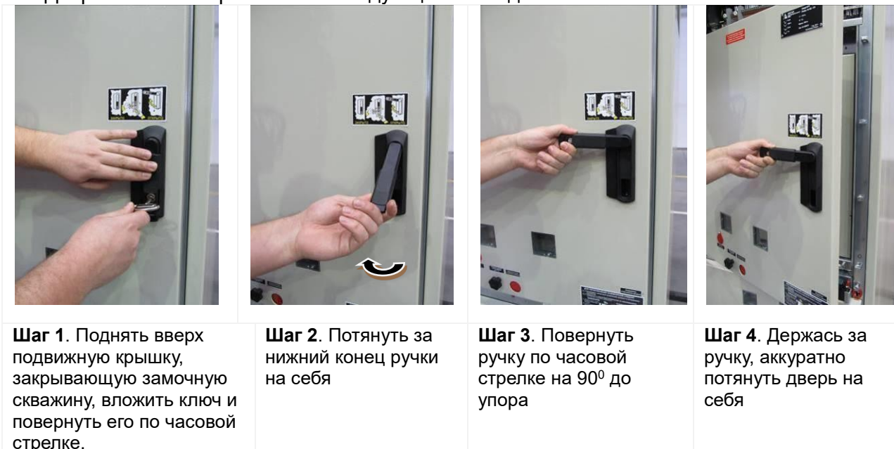
Рис. 2.2 Последовательность действий по открывание двери
