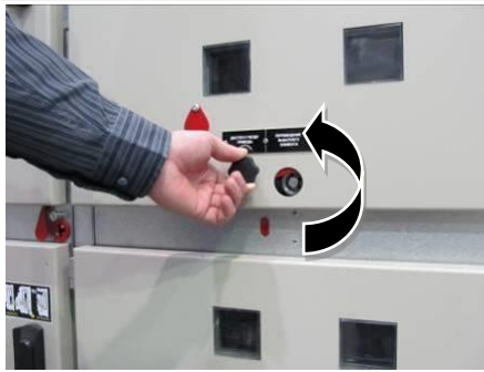
Рис. 2.3 Доступ к гнезду оперирования КВЭ
