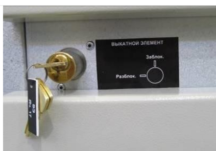
Рис.1.32 Замковая блокировка перемещения КВЭ
