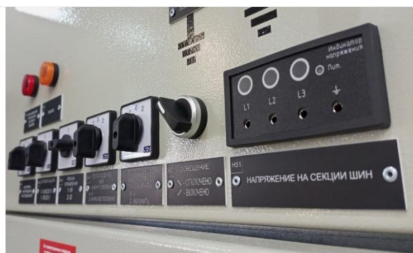
Рис. 1.20 Индикатор наличия напряжения
