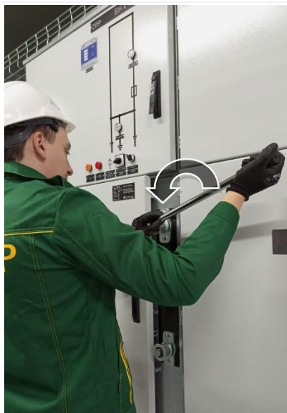
Рис. 2.16 Включение ВН
