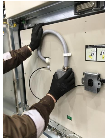
Рис. 2.22 Отсоединение разъема вторичных цепей
