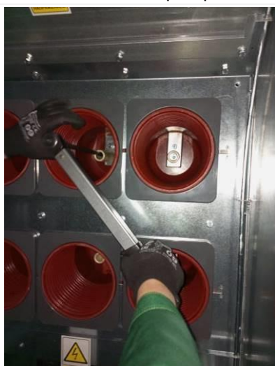
Рис. 3.8 Демонтаж контактов (пример)
