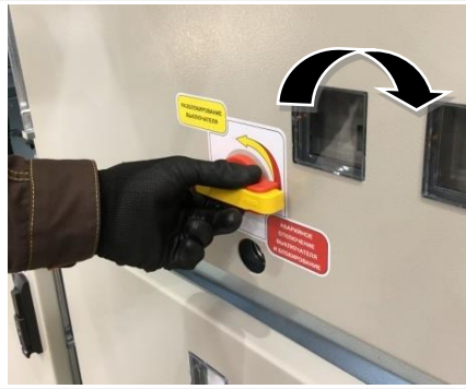
Рис. 2.6 Доступ к гнезду оперирования КВЭ
