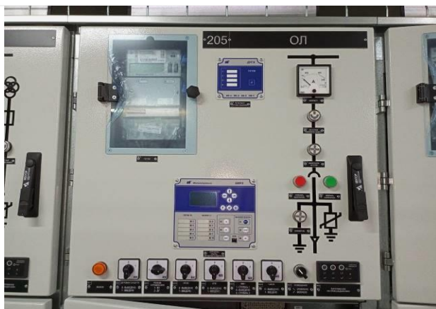
Рис.1.7 Фасад отсека вспомогательных цепей
