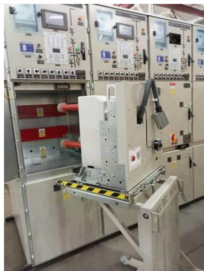
Рис.1.18 КВЭ в ремонтном (сервисном) положении
