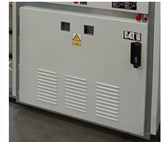
Рис. 1.47 Вентиляционные отверстия в двери отсека присоединений
