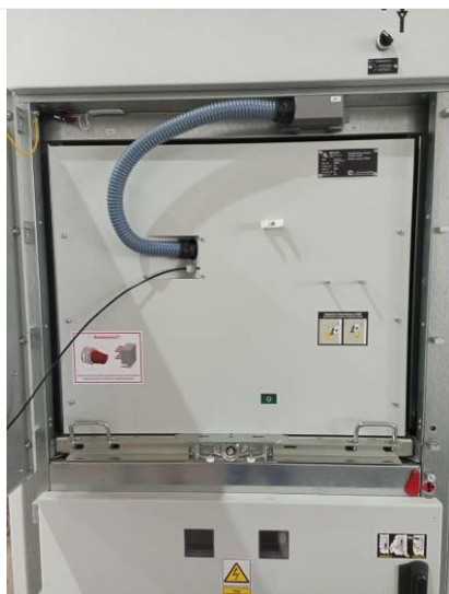
Рис.1.17 КВЭ в контрольном положении (вид при открытой двери)
