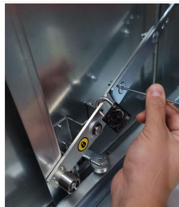
Рис. 3.7 Разблокирование нижней шторки
