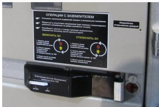
Рис. 2.32 Фиксация и сборка в отключенном положении
