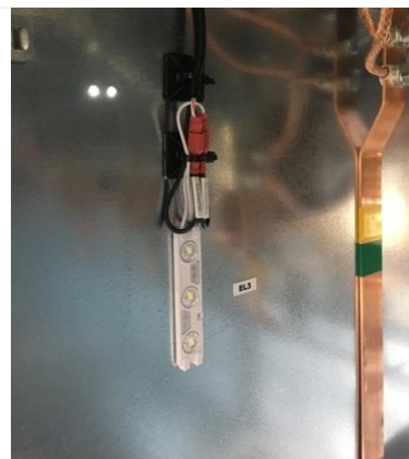
Рис. 1.48 Светодиодный модуль освещения отсека присоединений
