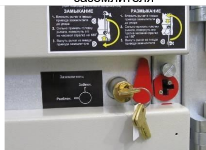
Рис.1.33 Замковая блокировка оперирования заземлителем
