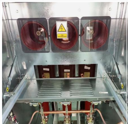
Рис. 3.5 Вид после демонтажа ревизионной панели и межотсечной перегородки
