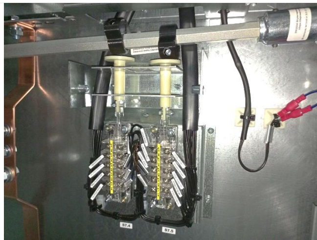
Рис. 1.22 Концевые выключатели клапанов сброса избыточного давления
