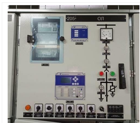
Рис. 2.14 Фасад отсека вспомогательных цепей с органами местного управления
