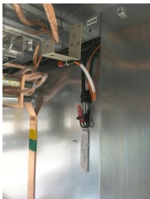
Рис. 1.44 Волоконно-оптический датчик в отсеке присоединений
