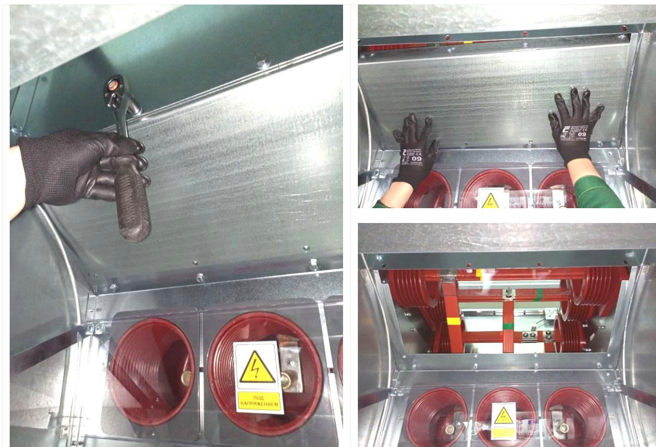
Рис.3.4 Организация доступа в отсек сборных шин с фасада шкафа
