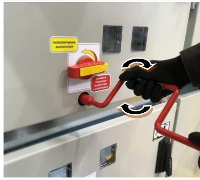
Рис. 2.7 Вращение винтовой передачи КВЭ
