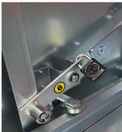
Рис.3.6 Место расположение навесного замка
