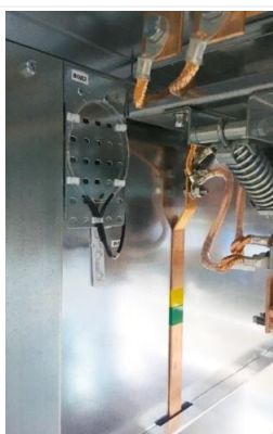
Рис. 1.44 Волоконно-оптический датчик в отсеке присоединений
