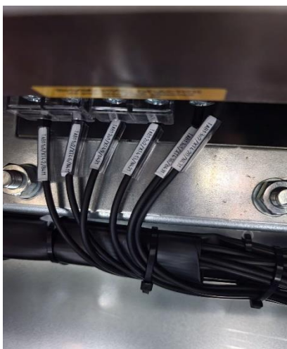
Рис. 3.9 Подключение вспомогательных цепей к ТТ
