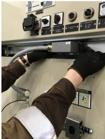
Рис. 2.22 Отсоединение разъема вторичных цепей
