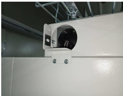
Рис.1.9 Отверстия для прокладки межсекционных связей
