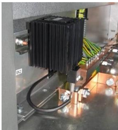
Рис. 1.49 Антиконденсатный нагревательный элемент
