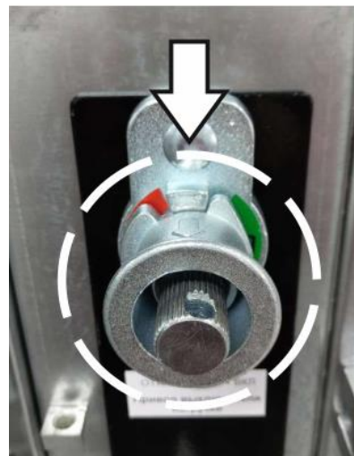
Рис. 2.17 Положение привода ВН перед началом эксплуатации
