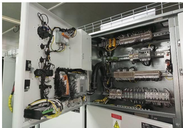
Рис.1.8 Отсек вспомогательных цепей (вид при открытой двери)
