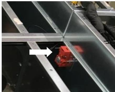
**Рис.4** Концевые выключатели клапанов сброса давления
