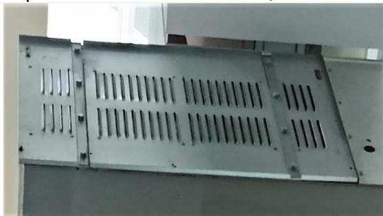
**Рис.3** Клапаны сброса давления
